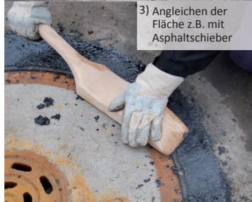
3) Angleichen der Fläche z.B. mit Asphalt-schieber
